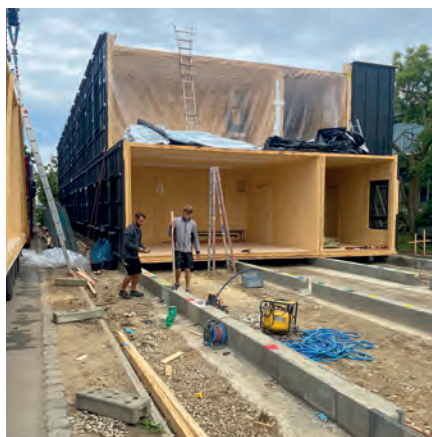
Bild-ID: Holzmodul Fundamentierung.jpg Bildunterschrift: Das easy-modul-System kann wahlweise auf Beton- oder Schraubfundamenten aufgebaut werden und bietet somit Planungsflexibilität für die Baustelle.
